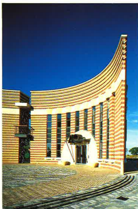
200 Aztec West, bedrijfsgebouw bij London
